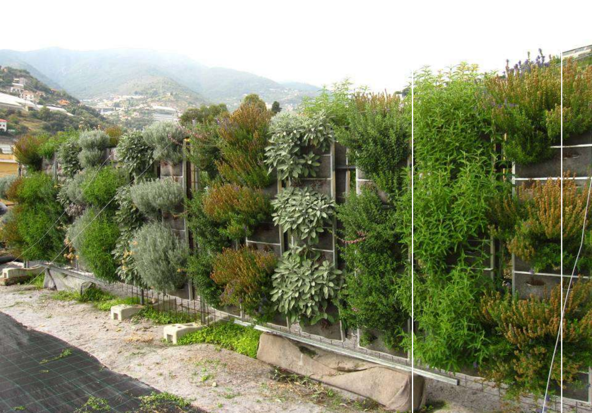
SANREMO, muro sud – ottobre 2010
