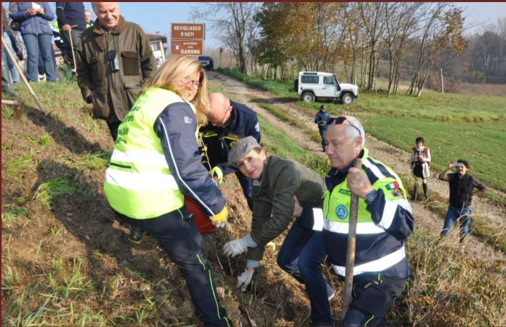
Messa a dimora delle piante per consolidare la scarpata franosa del tratto di strada Sp 8 con lo scavo delle buche da parte del Sindaco di Mongardino, Arch. Barbara Baino con l'aiuto di personale della Protezione civile di diverse realtà regionali italiane
