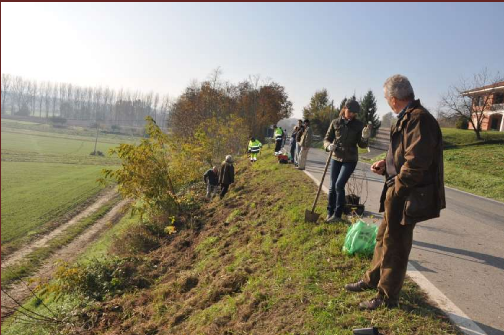
Avvio delle operazioni di messa a dimora delle piante per consolidare la scarpata franosa del tratto di strada Sp 8 con lo scavo delle buche da parte dei volontari
