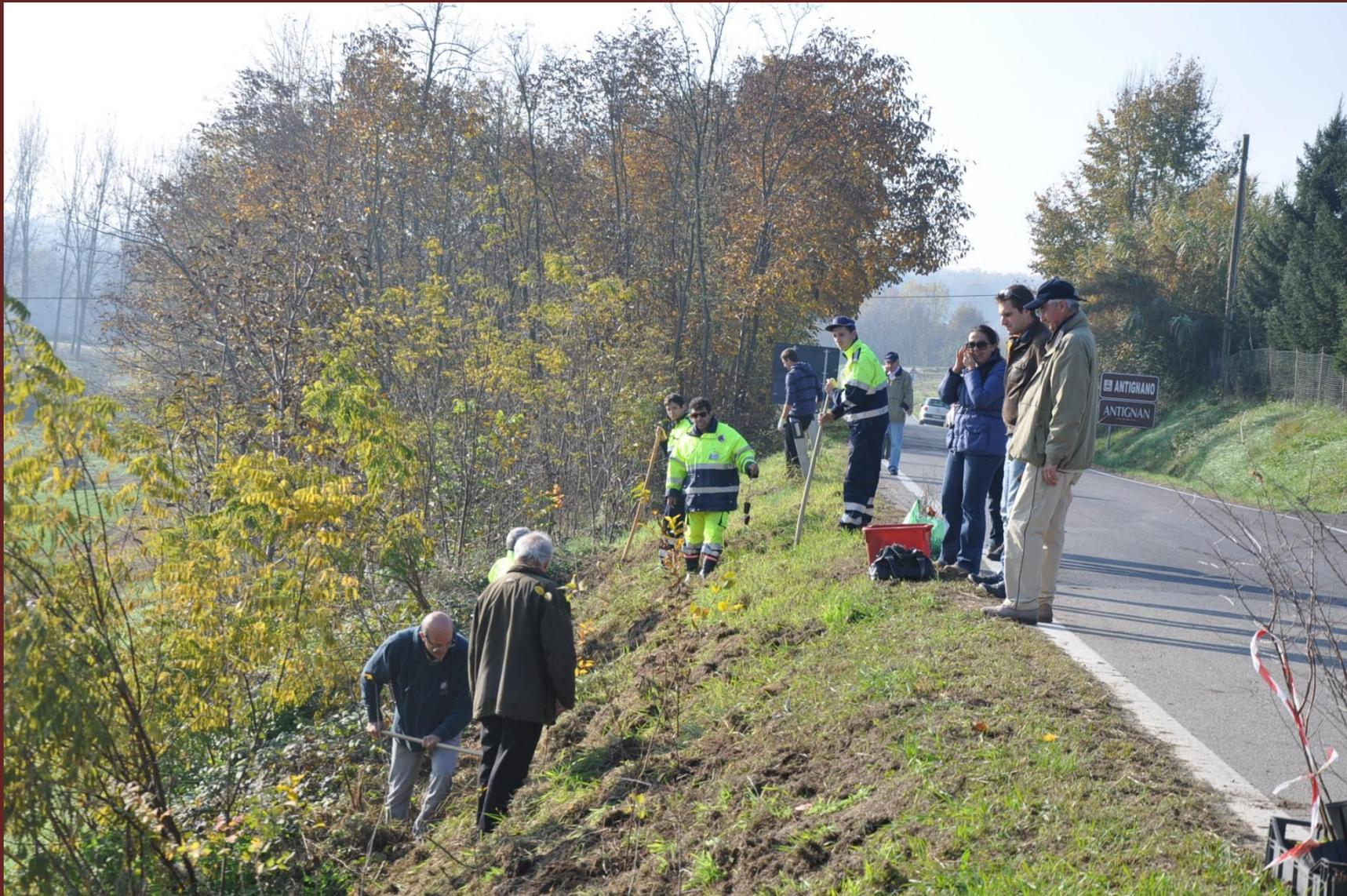
***Messa a dimora delle piante con lo scavo delle buche da parte dei volontari per consolidare la scarpata franosa del tratto di strada Sp 8 nel comune di Revigliasco d'Asti***
