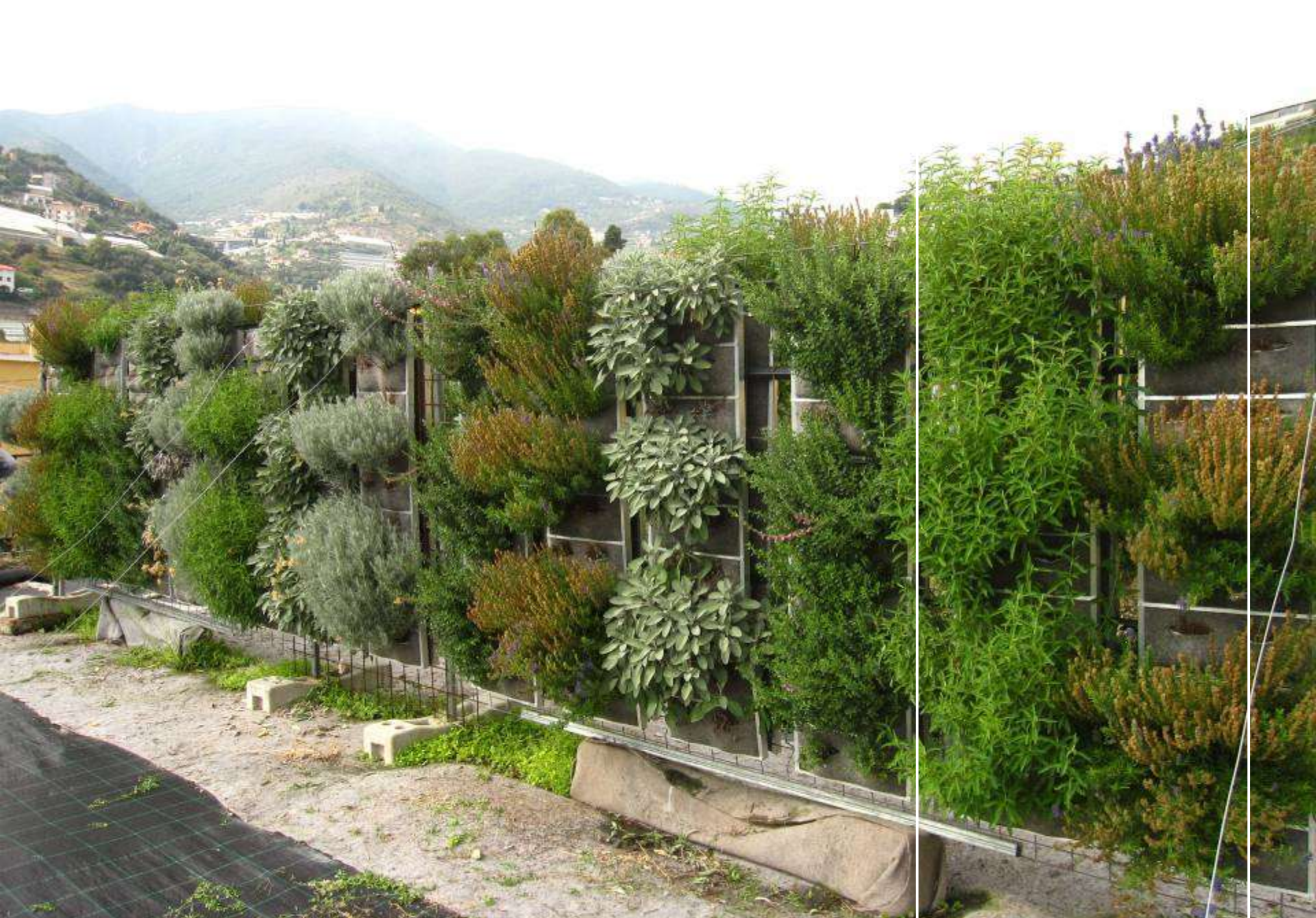
SANREMO, muro sud – ottobre 2010
