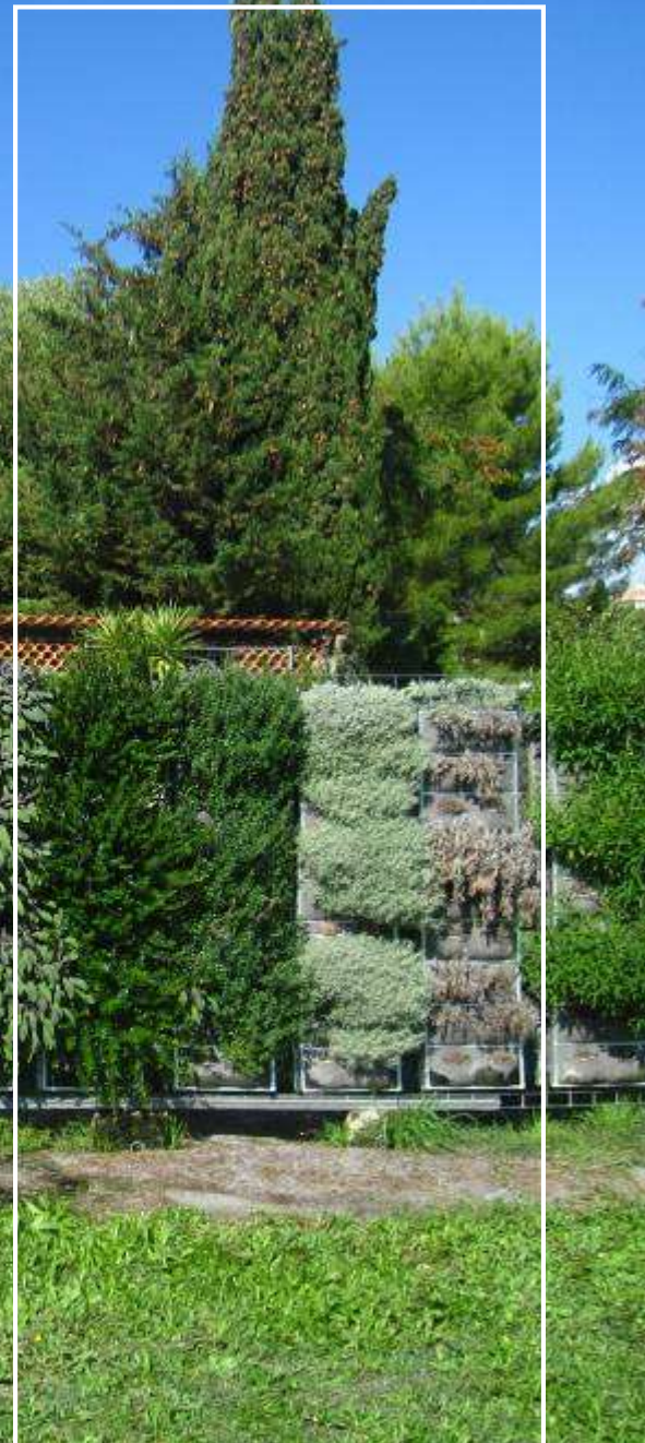
ANTIBES, muro est – ottobre 2010
