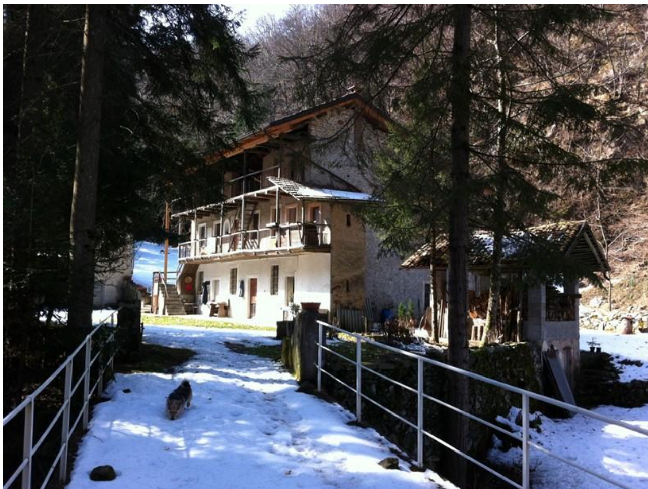
Foto 3 Ponte d'ingresso al cascinale
