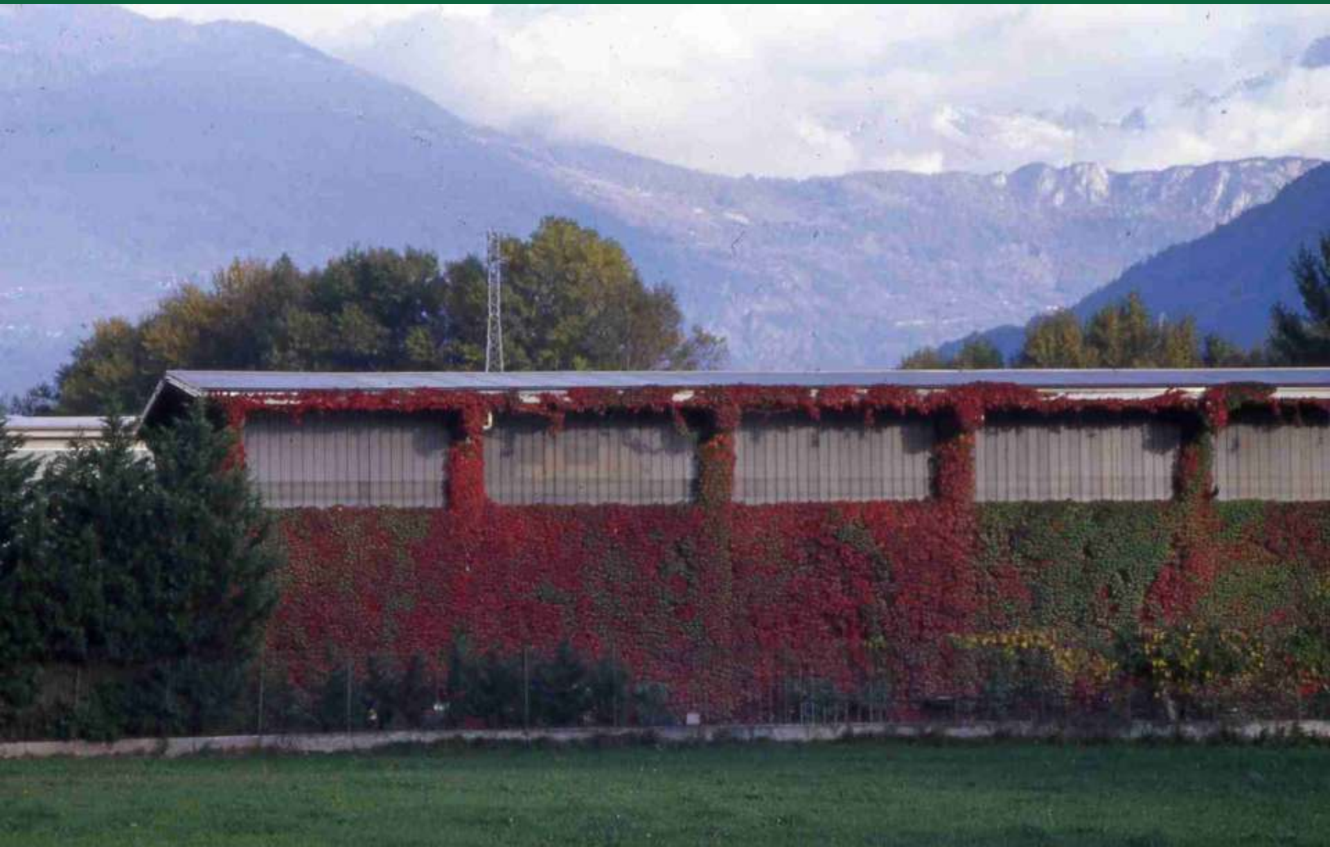
Capannone rinverdito con l'impiego della specie Parthenocissus tricuspidata
