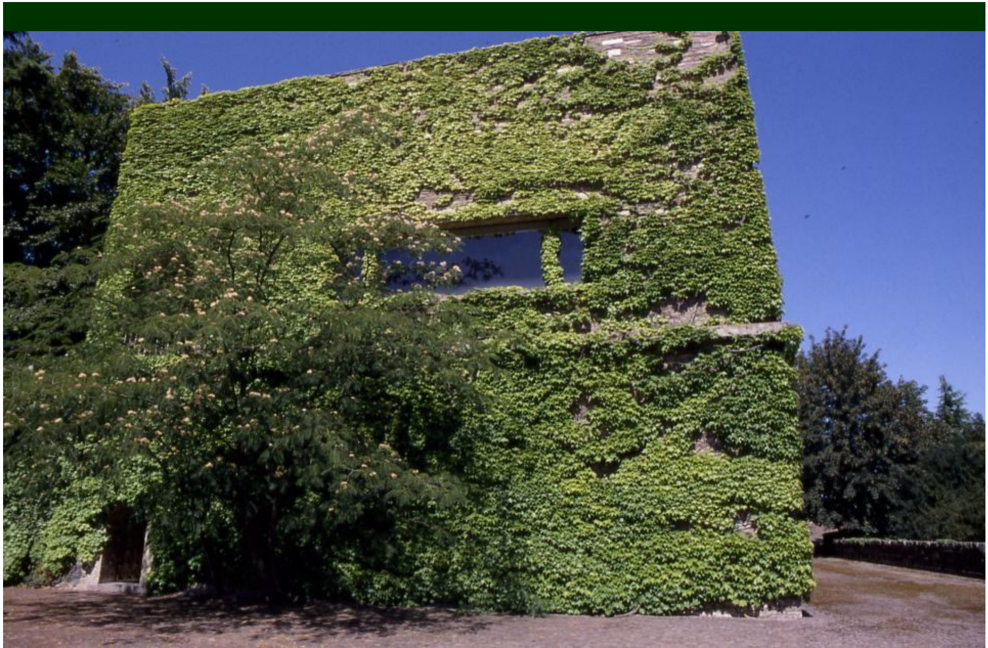
Parete verde realizzata su progetto dal paesaggista Pietro Porcinai Cantina della Tenuta Monterosso ad Acqui Terme (AL)
