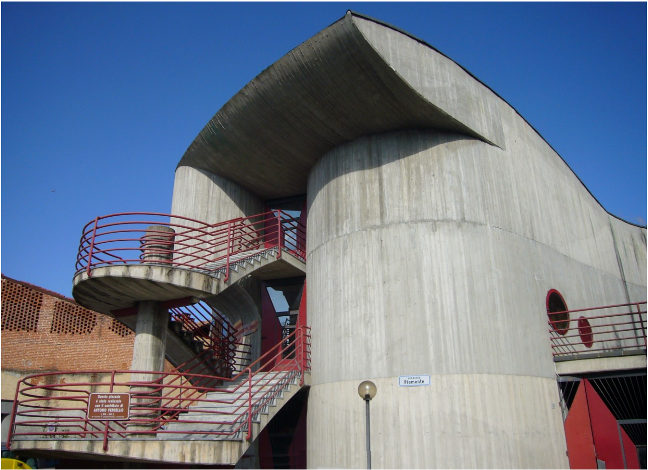
Arch. Giulio Balbo – Municipio di Castelnuovo Don Bosco (1977-1993)
