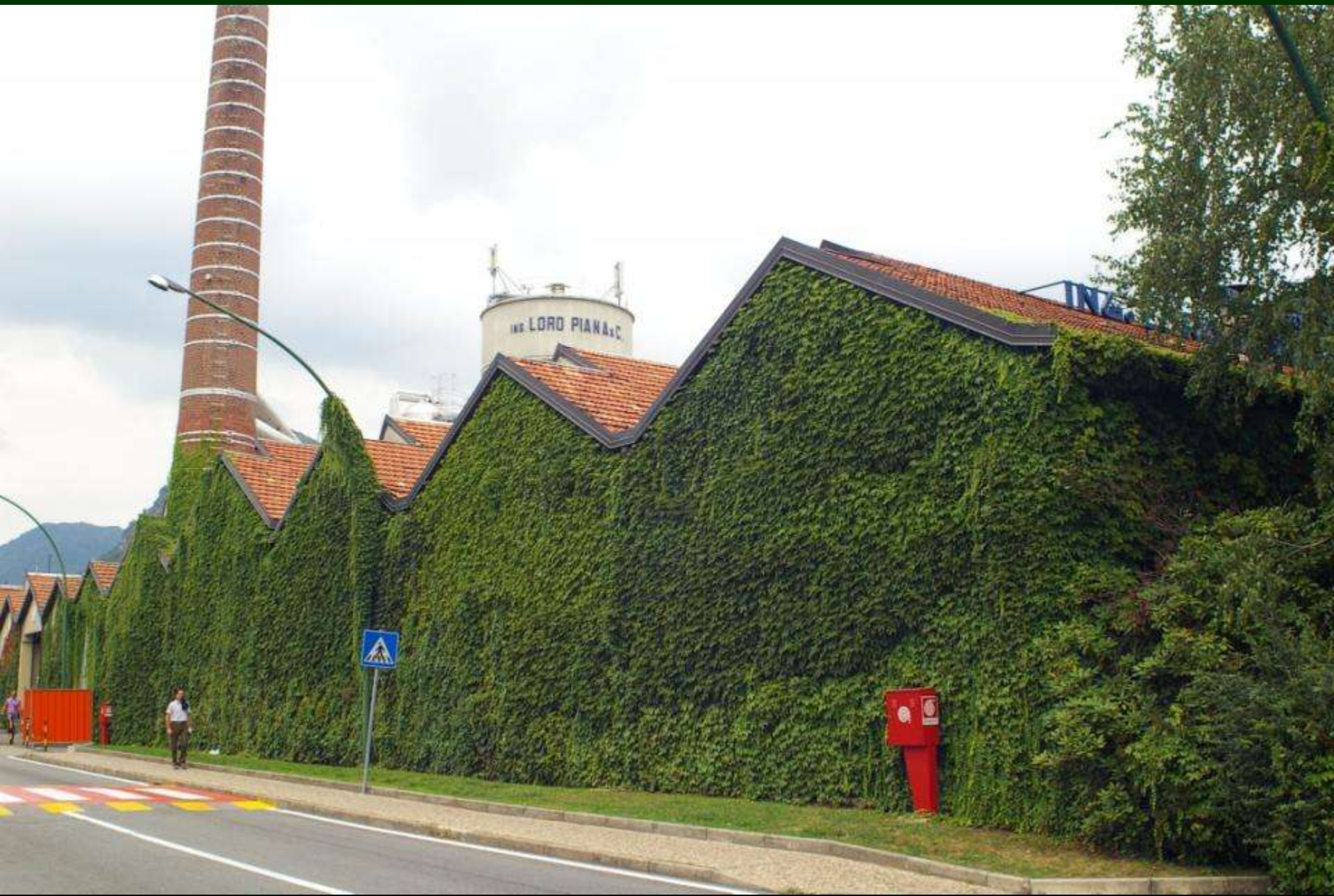
Capannone rinverdito con l'impiego della specie Parthenocissus tricuspidata
